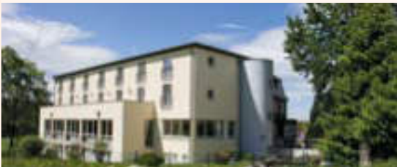
Hotel Haus Oberland | Masserberg
